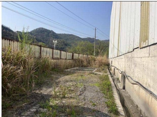
采矿区沉淀池
