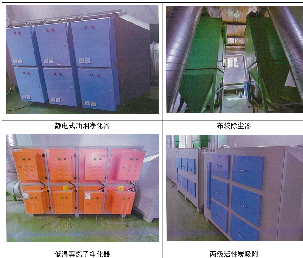
图 4.1-1 拆解脱锡废气处理设施
