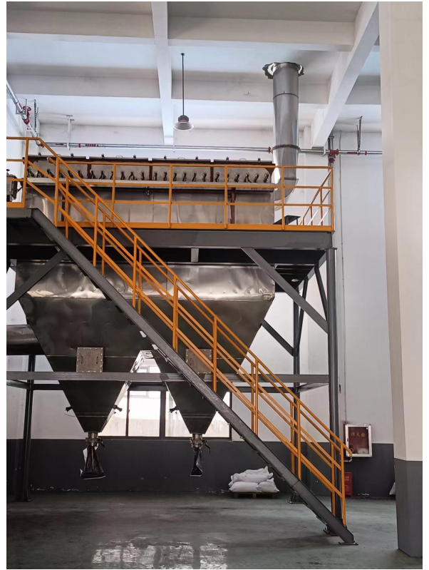
喷雾干燥废气布袋除尘器
