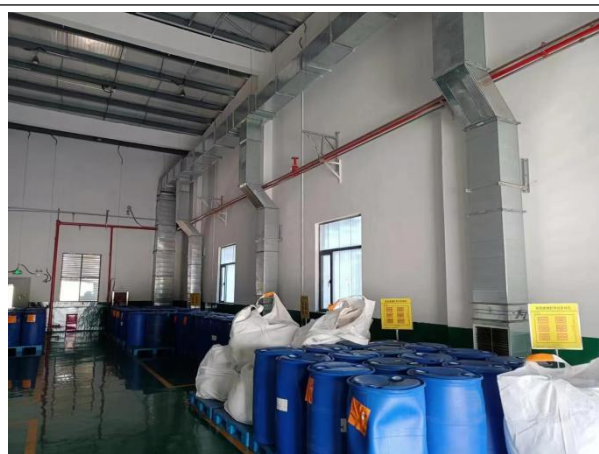
危废库现状（地面硬化、防渗措施）
