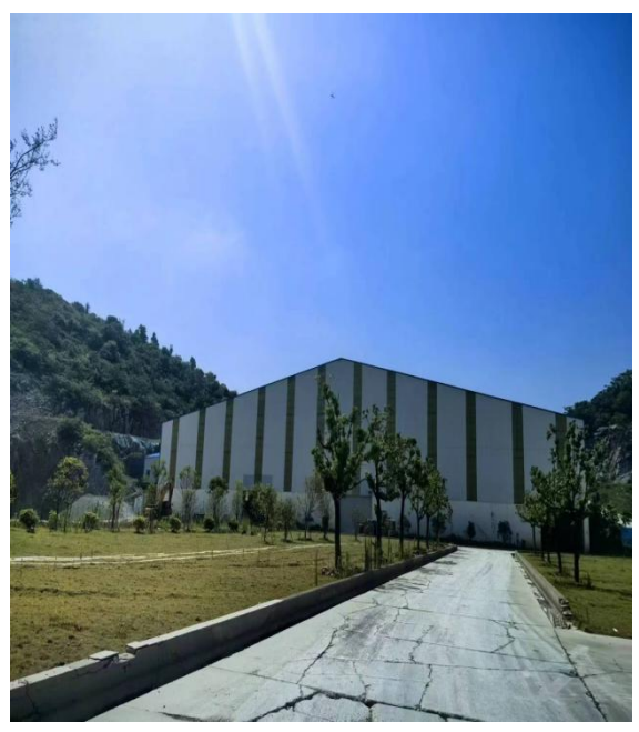
破碎车间外景
