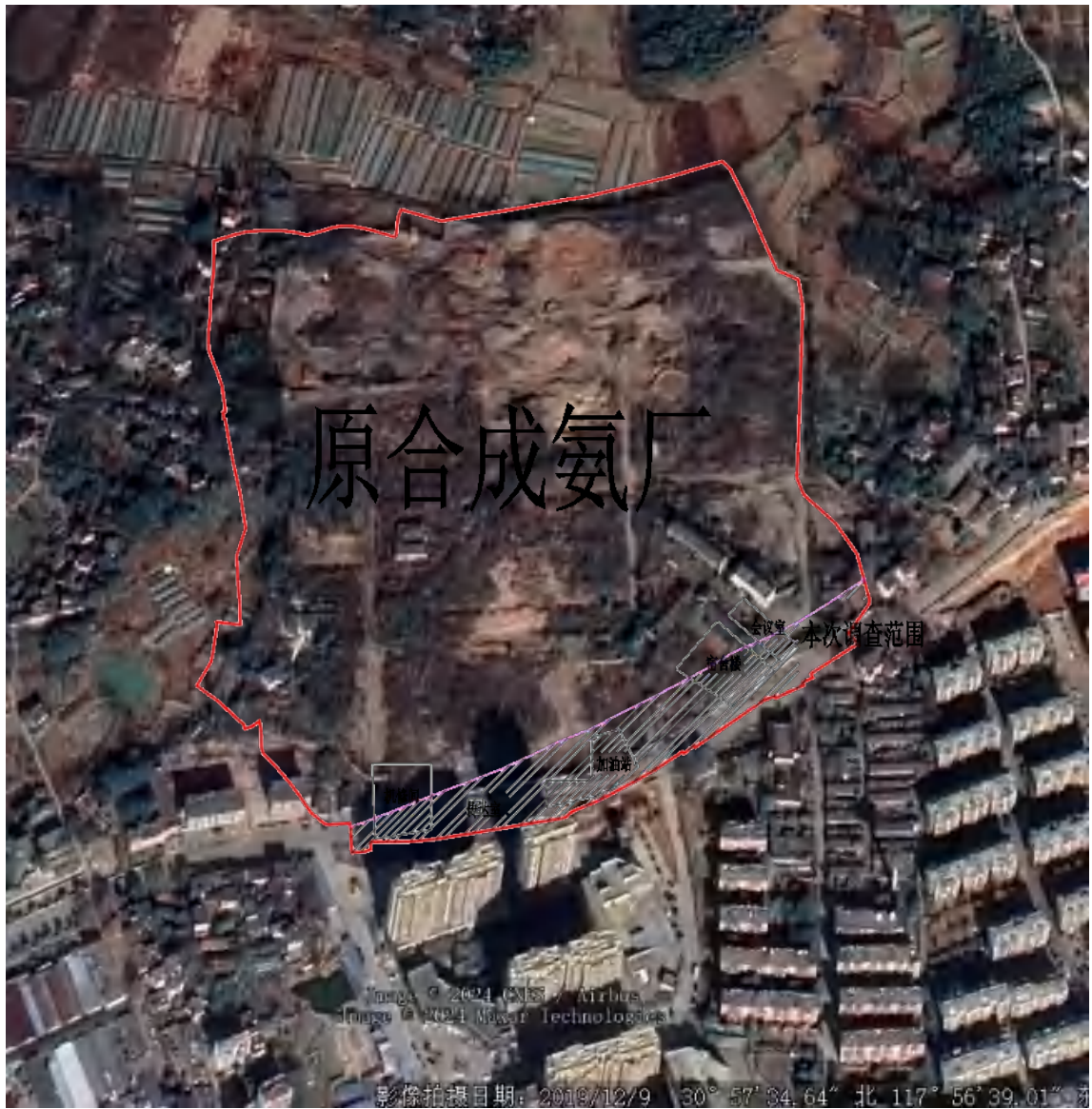
图中可知2019年合成氨厂已进行相关设备及厂房拆除，本次调查地块属于合成氨厂部分区域，均已拆除。
