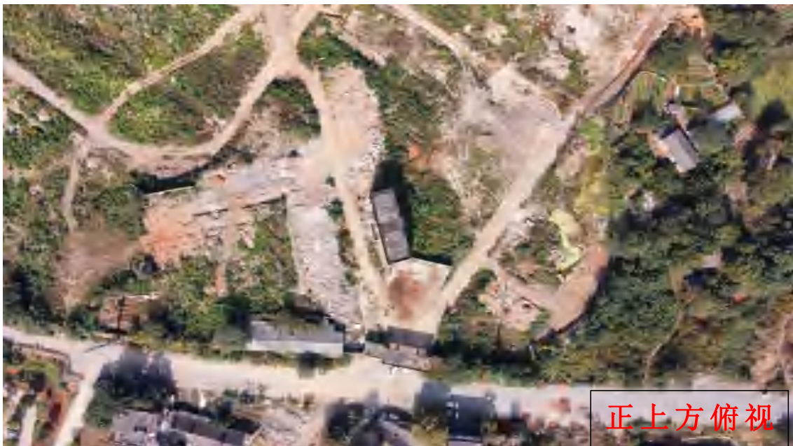
图3-9 调查地块地形地貌航拍图（俯视图）
